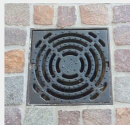
Boca tormenta coladera
